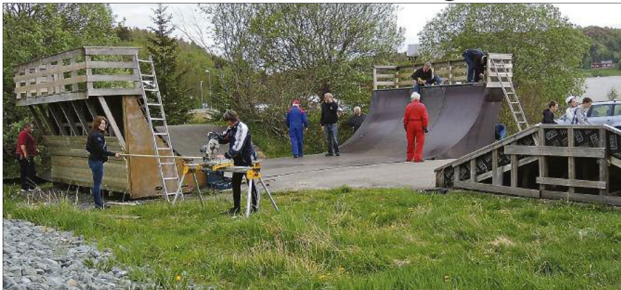
REPARASJONSARBEIDET er utført av Rotary-medlemmer over to mandagskvelder.
