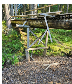
Verdal Svartfossen Stabilisere broen, og bygge nytt rekkverk
